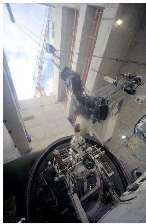
Puits d'entrée du tunnelier pour le prolongement de la Ligne 12 du métro (source : RATP)
