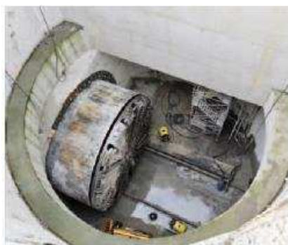
Puits de sortie du tunnelier pour le prolongement de la Ligne 12 du métro (source : RATP)
